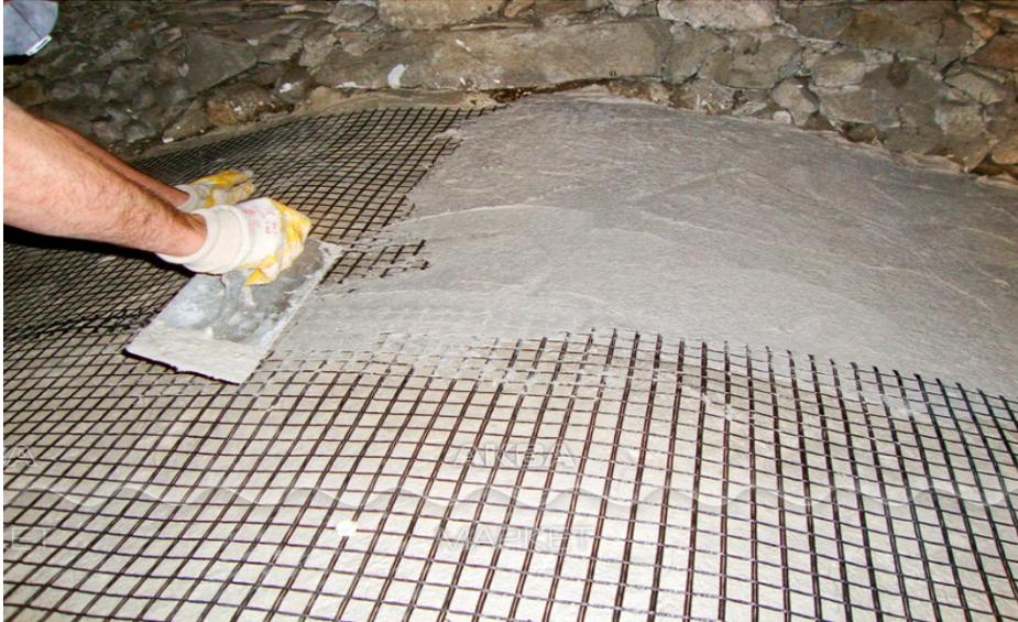
Colocación de mortero dúctil sobre malla de refuerzo Pozzolime-Grid-225
