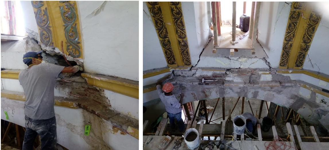
Refuerzo de cúpulas con mortero reforzado con macrofibras Pozzolime® FX
