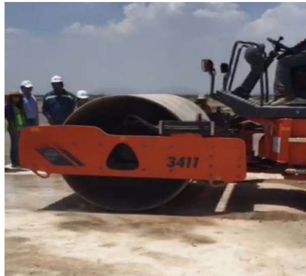
Losa-Prueba de Deformabilidad
