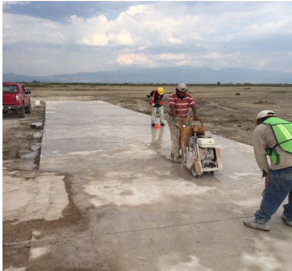
Losa terminada en proceso de corte
