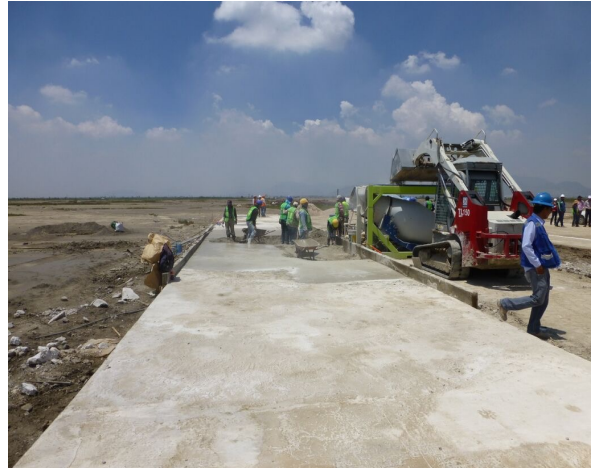
Colado y extendido de la losa
