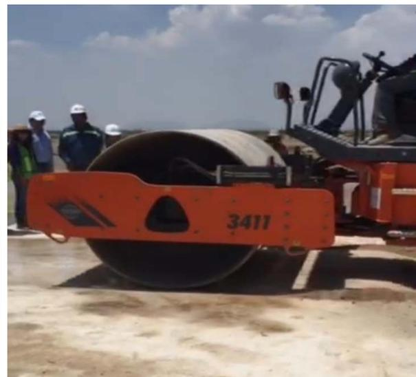
Losa-Prueba de Deformabilidad
